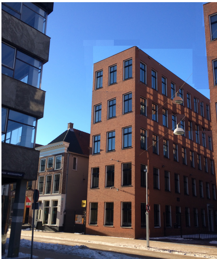
OB 18 na optopping met een vijfde laag
