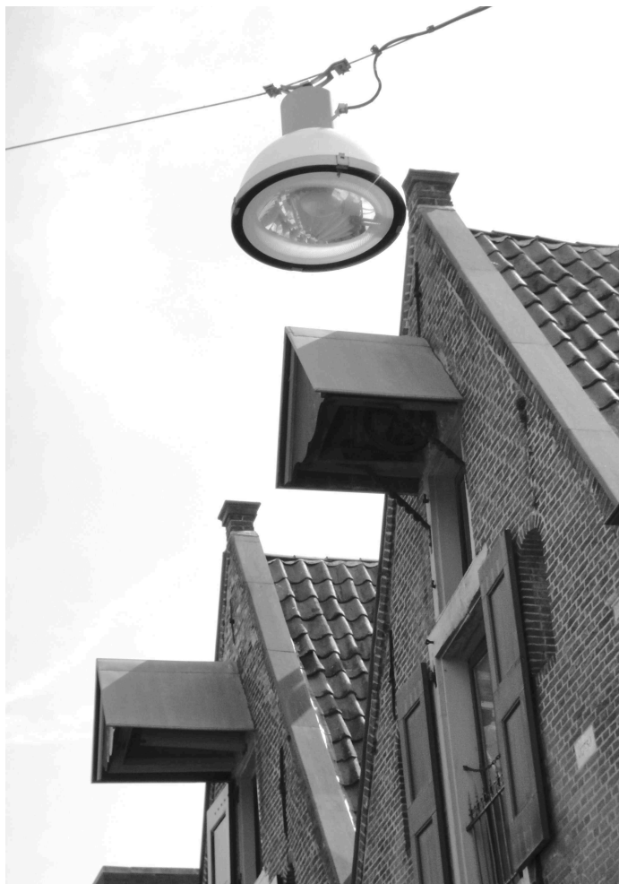
Trijshuisjes aan de gevels van de pakhuizen 'Amsterdam' en 'Hamburg', Hoekstraat (foto's: Tom van der Meulen)
