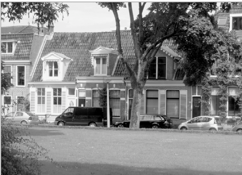
[Afb 2] Eenlaags huisjes aan het Nieuwe Kerkhof
