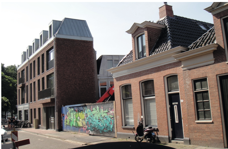
Het gat in de Westerhavenstraat naast de nieuwbouw
