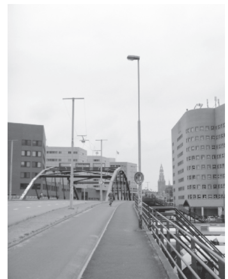
Emmaviaduct, poort naar stad
