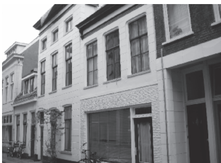
Visserstraat 29 t/m 33 voor de sloop
