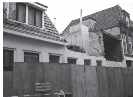
Visserstraat 29 t/m 33 tijdens de sloop
