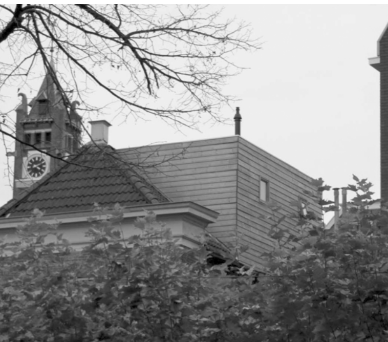
Gedempte Zuiderdiep 140 (beschermd stadsgezicht). De dakopbouw is niet volgens de omgevingsvergunning gebouwd.
