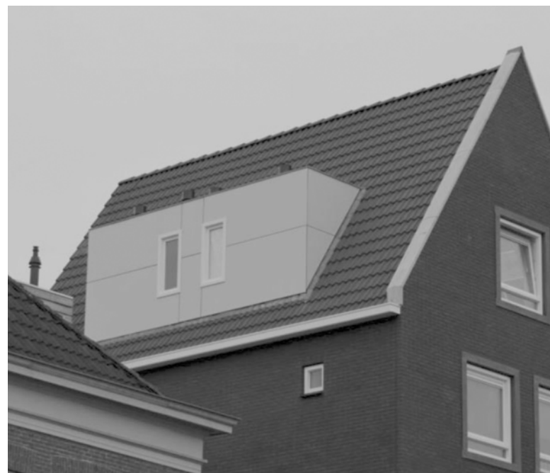
Gedempte Zuiderdiep 144 (beschermd stadsgezicht). Een dakkapel dient een ondergeschikte toevoeging aan het dak te zijn.
