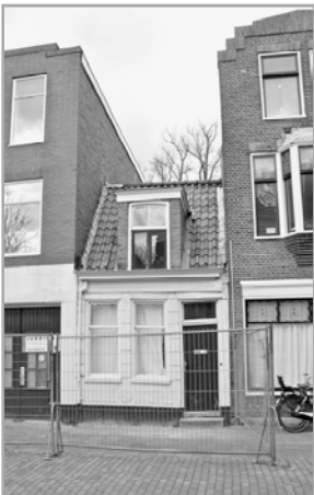
Sloop en nieuwbouw Kleine Leliestraat 27; foto's: Bob van Dijk
