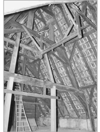
Foto: Vismarkt 40, kapconstructie uit de 16e eeuw. Vermoedelijk de grootste kap op een woonhuismonument in de stad.
